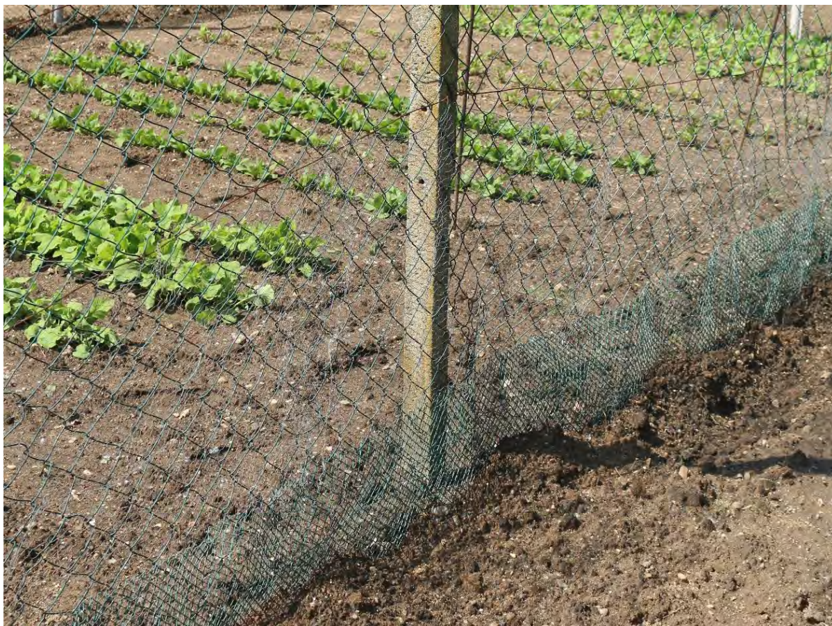
Obr. P5.34 Oplocená zahrada v Hrušovanech u Brna: klasický plot s plotovým pletivem je kombinovaný s králíčím pletivem v dolní části.
