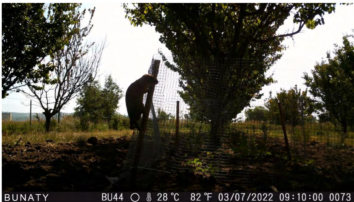
Obr. P5.34 Oplocená zahrada v Hrušovanech u Brna: klasický plot s plotovým pletivem je kombinovaný s králíčím pletivem v dolní části.
